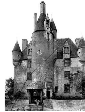
Château du Châtelier - Pommiers
