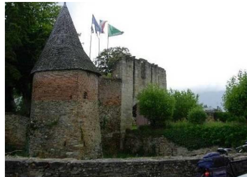
Vestiges du Château d'Eguzon
